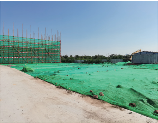
利用安全防护拆卸的安全网进行裸土覆盖
